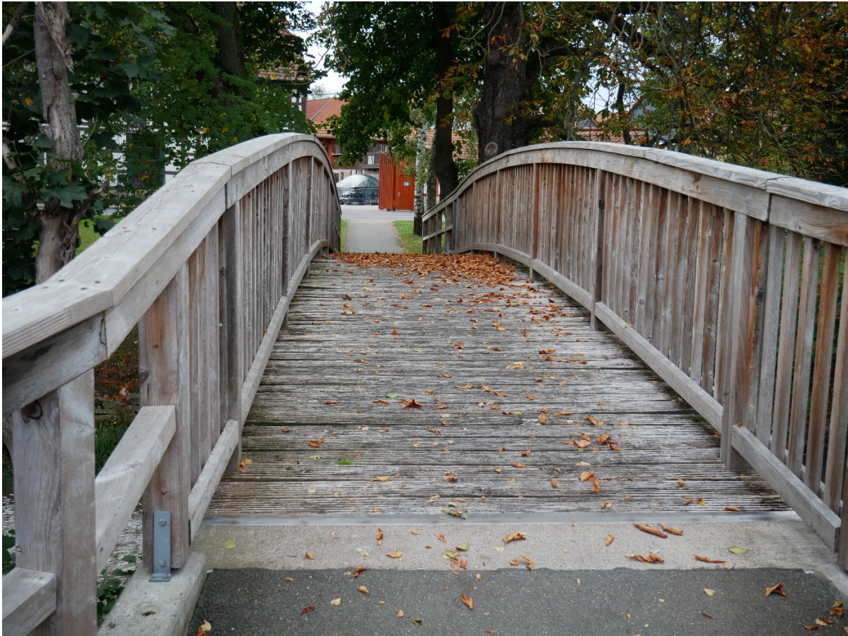
Abbildung 3: Ilmbrücke, Quelle: ThLG
